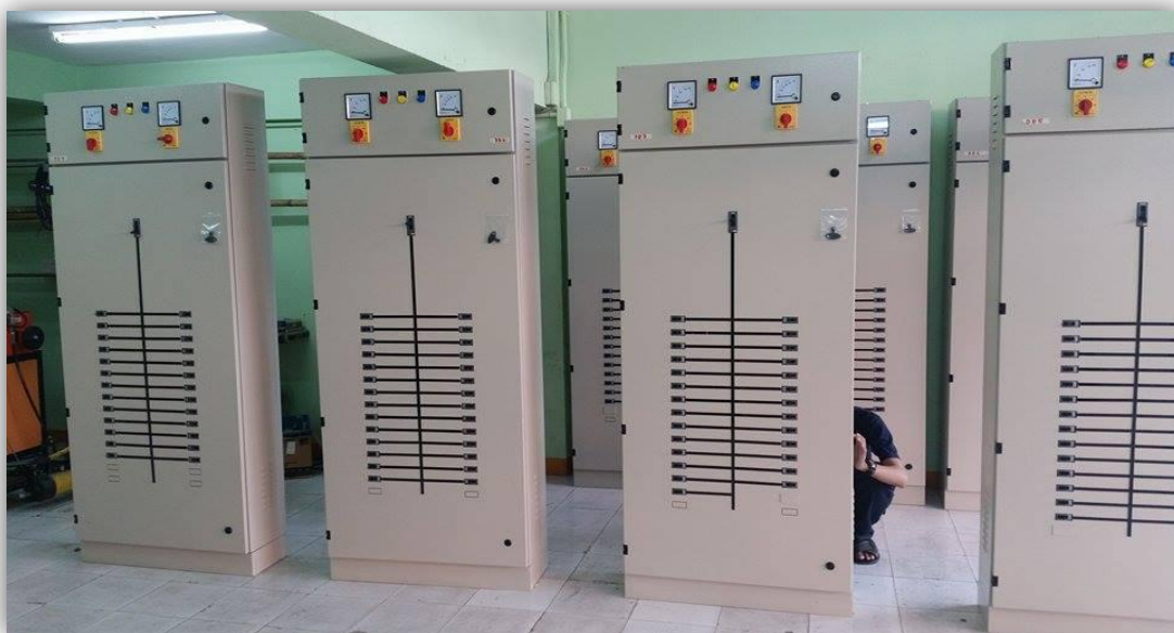
งานระบบเดินท่อร้อยสายไฟฟ้า โครงการ คอนโด พัทยา
